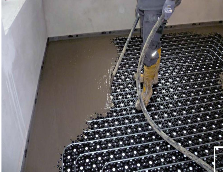
Aanbrengen van de Sopro Nivelleer FS 15 plus 550 met een pomp.
