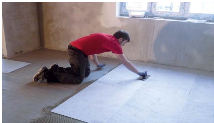
Verlijming van de Sopro tegelisolatieplaat FDP 558 met Sopro's No.1.
