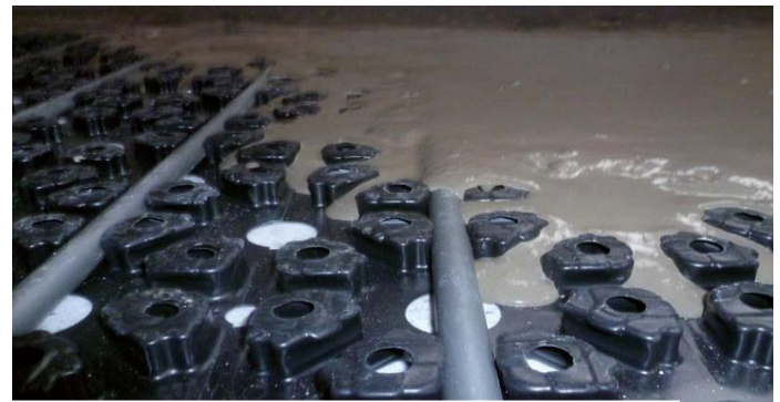
De Sopro Nivelleer FS 15 plus 550 vult het Kermi x-net C15 dunne-laagsysteem.
