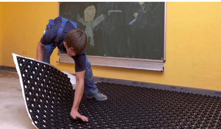
Legging van het Kermi x-net C15 dunne-laagsysteem. Bron: Kermi GmbH
