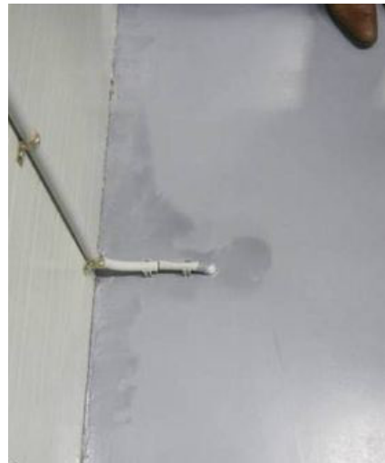
Figuur 5-14 Voorbeeld uitloop pigment.
