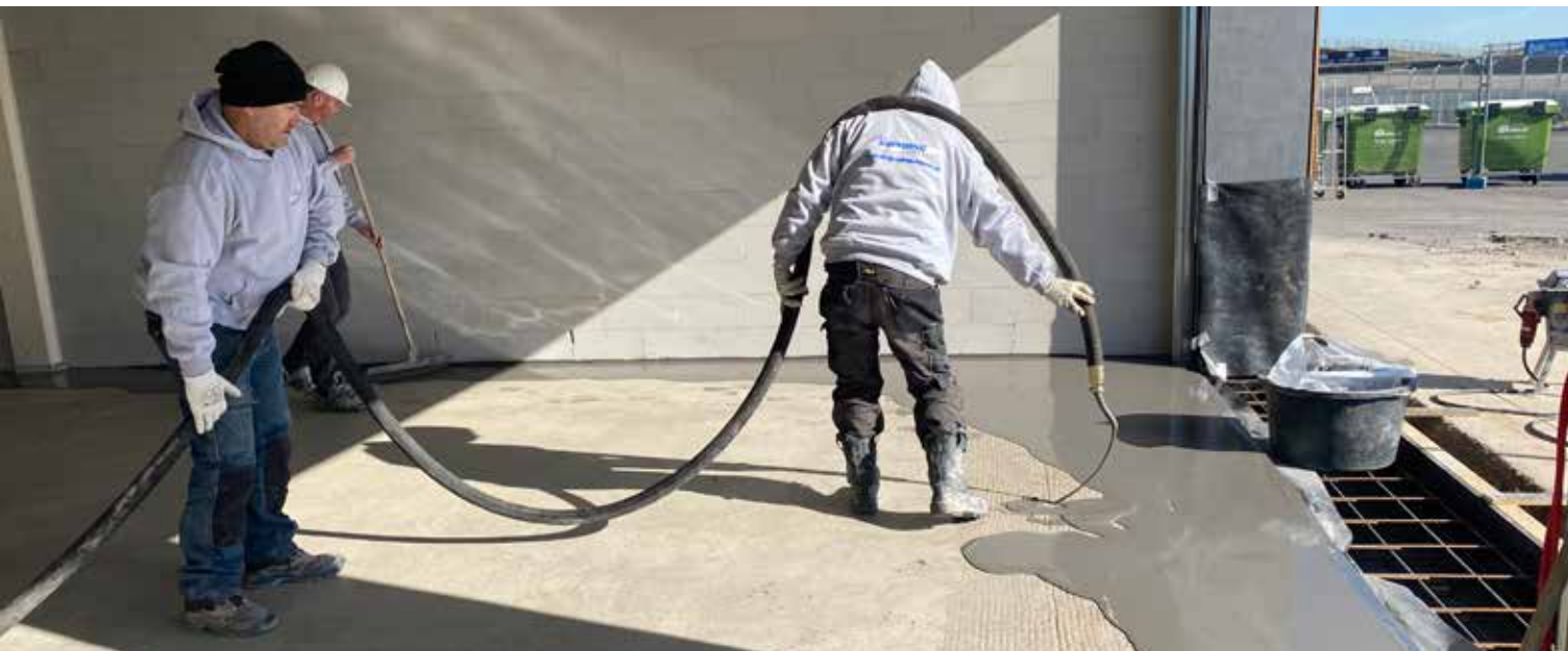
De vloeibare mortel stroomt door de slang in een dunne laag over de paddockvloer.
