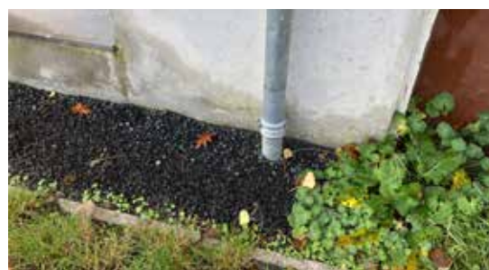
Aan de onderzijde van de gevelafwerking komt net boven maaiveldniveau vochtschade en holklinkend stucwerk voor.
