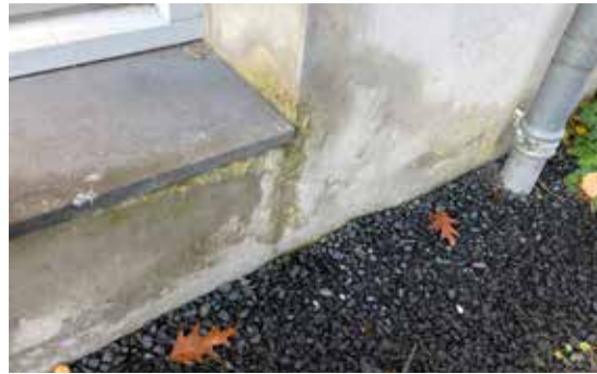
De aansluiting tussen hardstenen waterslag en stucwerk is niet waterdicht afgewerkt.
