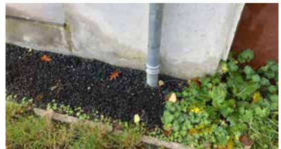
Aan de onderzijde van de gevelafwerking komt net boven maaiveldniveau vochtschade en holklinkend stucwerk voor.
