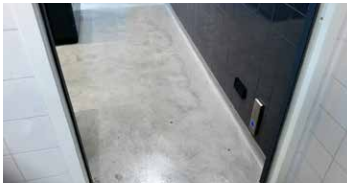
Spaanslag en patroon wijzen niet op materiaalsamenstelling als oorzaak, maar op vervuiling.
