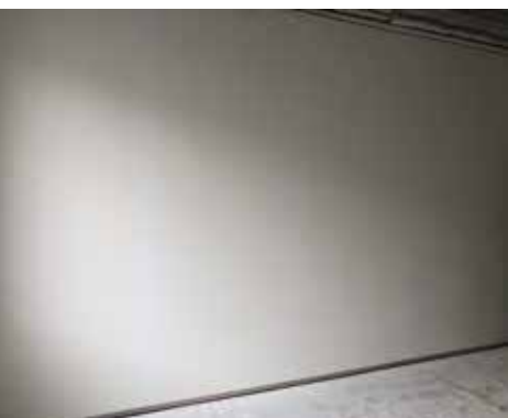
Geelverkleuring spacksputwerk
