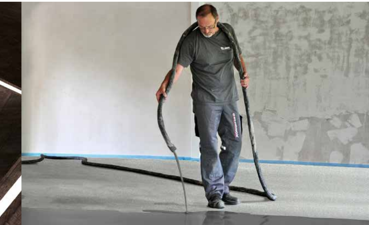
De mortel, waar gips én cement in zit, kan eenvoudig gegoten worden.
