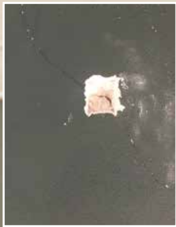
Slaapkamer, aansluiting plafond.
