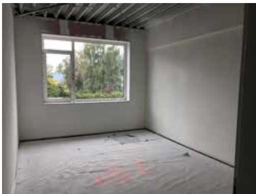
Voorbeeld lichtinval in de ruimtes
